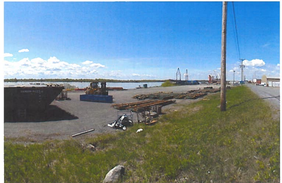
Vue de la partie Ouest de l'aire d'interventions A1, depuis la rue Robert-Cauchon, à environ 100 m de Les Grains Lac Supérieur (Avril 2013)
