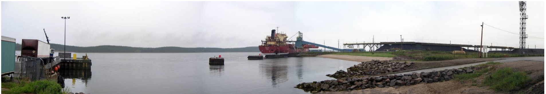
Photo 2. Vue panoramique sur le quai de la corporation (extrémité gauche), de la rampe de mise à l'eau (partie inférieure droite) et des installations de RTFT (partie supérieure droite).
