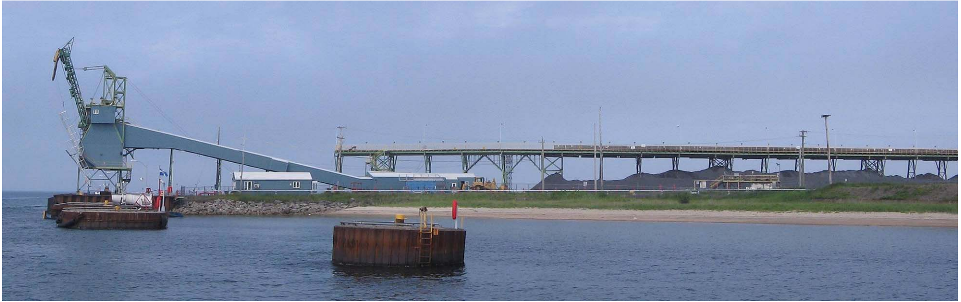
Photo 1. Vue sur les installations de RTFT à partir du quai de la Corporation. La tour de chargement est à l'extrémité gauche. Les ducs-d'Albe A (centre) et B (extrémité gauche) apparaissent sur cette vue. La structure aérienne du centre à l'extrémité droite est le tréteau de la voie ferrée servant au déchargement des wagons de minéra.
