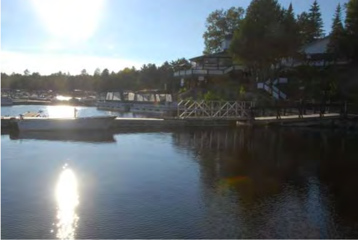
Figure 4. Quais de la marina installés en face des bâtiments principaux.
