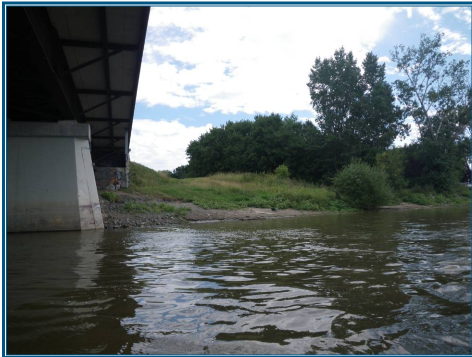
Photo 8 : Accès en aval du pont Le Gardeur – Repentigny.
