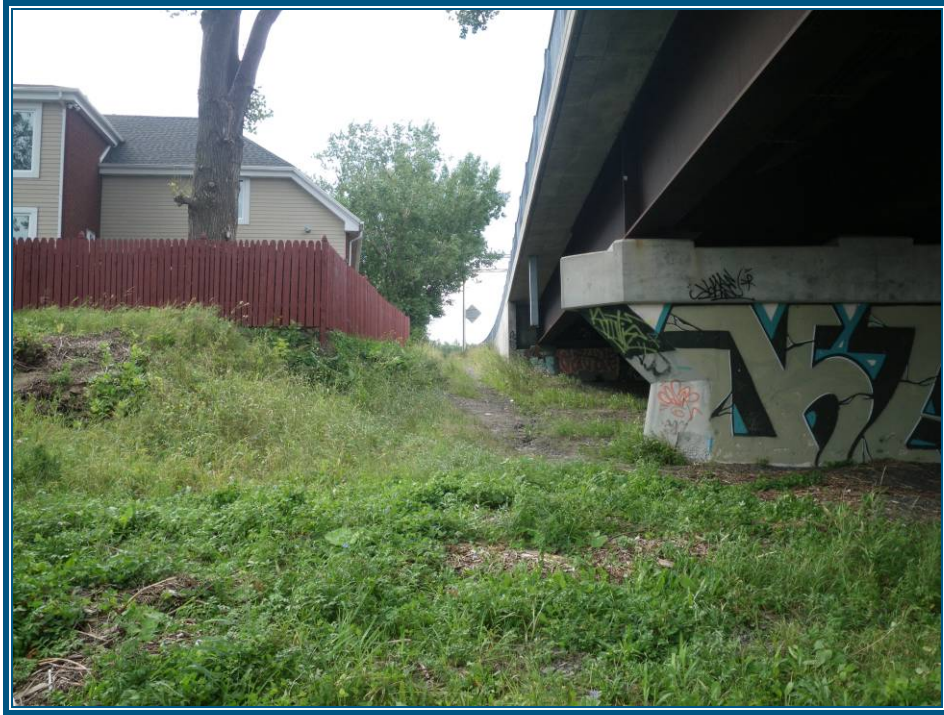
Photo 1 : Aval du pont Le Gardeur - île de Montréal.
