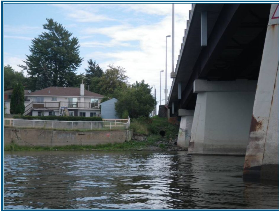
Photo 9 : Côté en aval du pont Le Gardeur – Repentigny.
