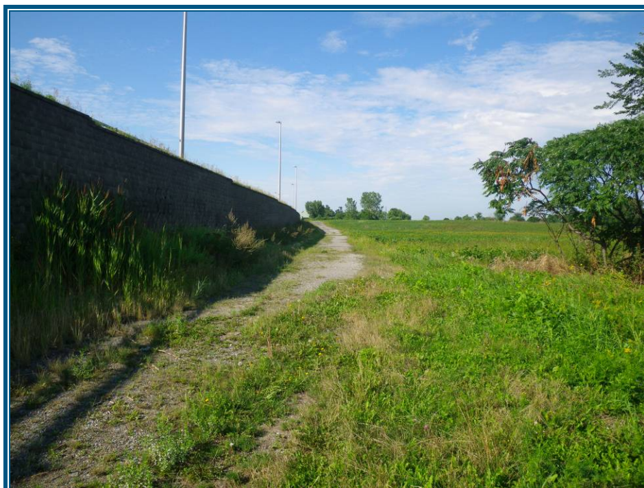
Photo 4 : Chemin d'accès en amont du pont Le Gardeur – île Bourdon.
