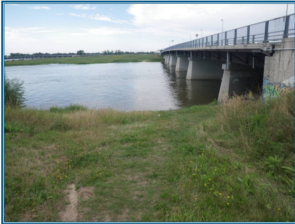
Photo 7 : Accès en aval du pont Le Gardeur – Repentigny.
