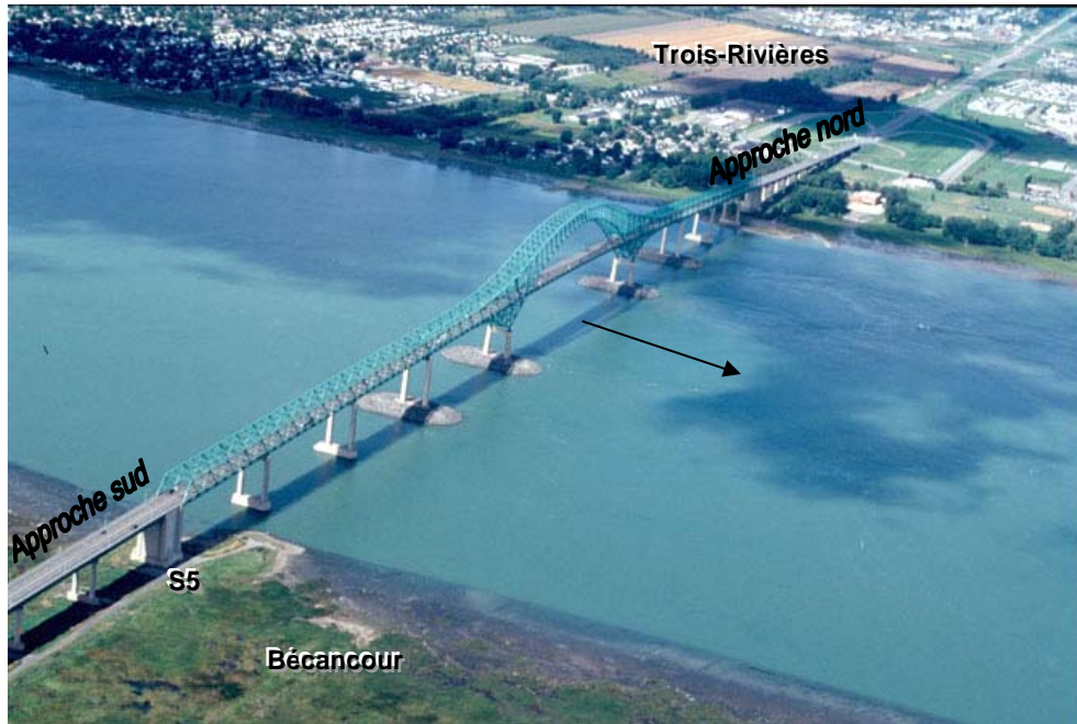
Photographie 1 : Vue aérienne du côté aval du pont Lavolette (date de prise de vue et niveau d'eau inconnus).
