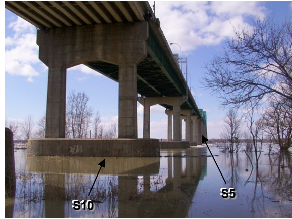
Photographie 3 : Chemin d'accès existant à la pile S5. À gauche, le niveau d'eau est à l'élévation 3,18 m le 11 août 2005; à droite, il se situe à 5,82 m le 8 avril 2005.
