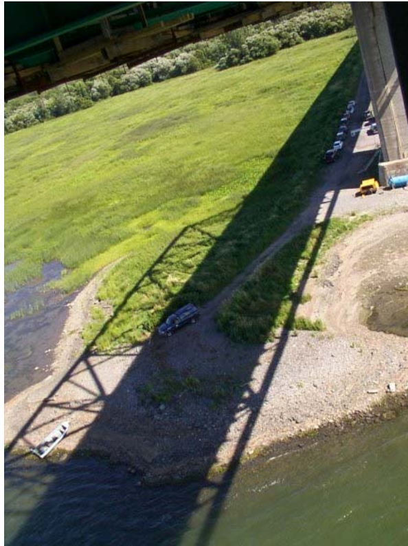
Photographie 7 : Remblai situé entre les piles S5 et S4.
