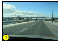
Viaduc de l'échangeur 318
