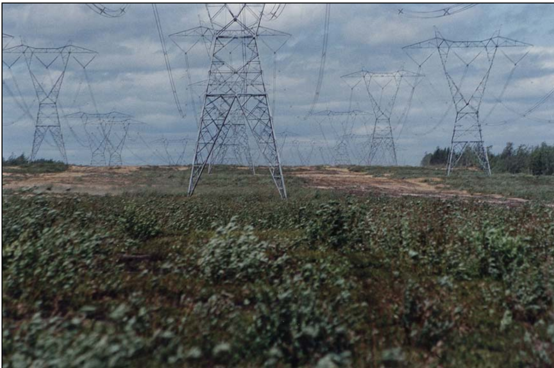
Photo 5-11 : Aménagement d'emprises – bleuetière
