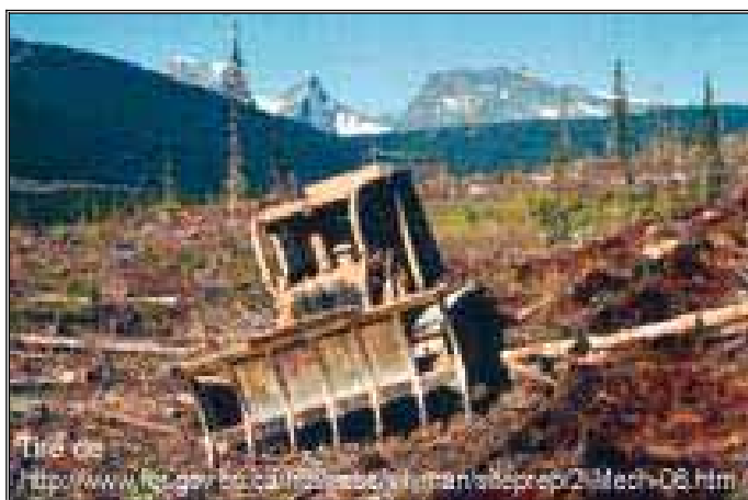
Figure 33 Bulldozer équipé d'un peigne
