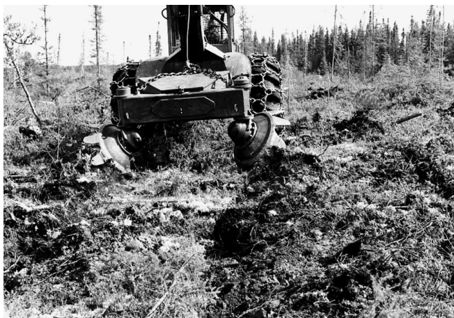
Figure 6. Préparation du terrain par scarifiage à disques. Le principal objectif du scarifiage est de créer, par un travail mécanique du sol, un environnement favorable à l'établissement et à la croissance des plants qui seront mis en terre.
