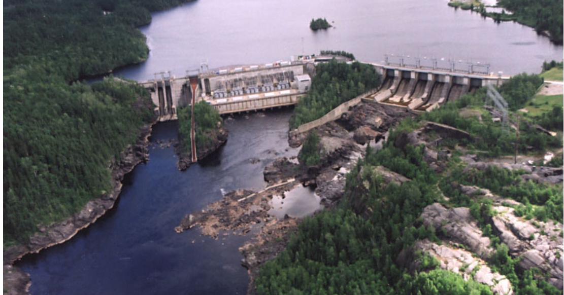
Centrale de la Chute-du-Diable
