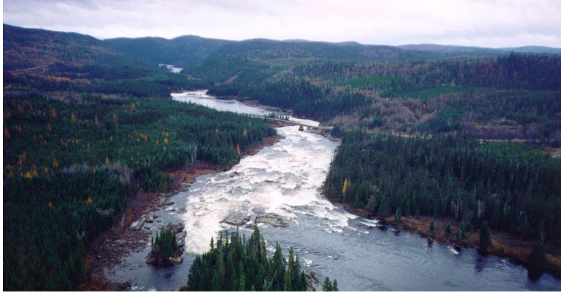
La Péribonka au pont du chemin de Chute-des-Passes
