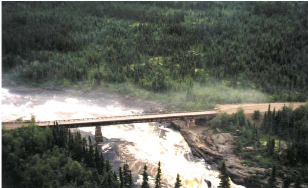
Pont du chemin de Chute-des-Passes
