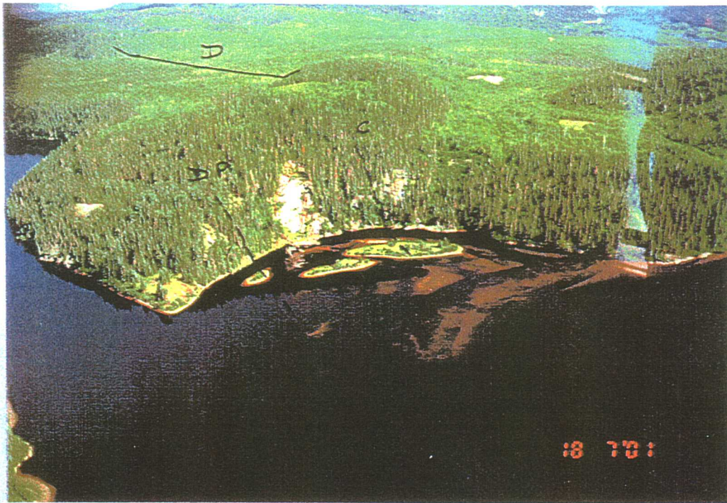
Vue, depuis l'aval, de la zone du canal de fuite de la dérivation provisoire (DP) et de la centrale de l'aménagement PER-3D ©. À noter la présence des abrupts rocheux. Le site de la digue (D) est à l'arrière-plan.
