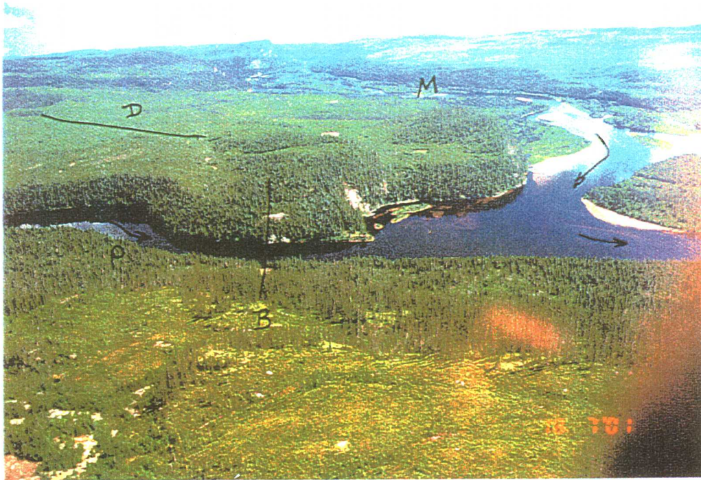
Vue, depuis le sud-ouest, de la confluence des rivières Péribonka (P) et Manouane (M) et du site étudié PER-3D, au pk 151.8 de la rivière Péribonka. On y distingue la zone du barrage (B) et celle de la digue (D).
