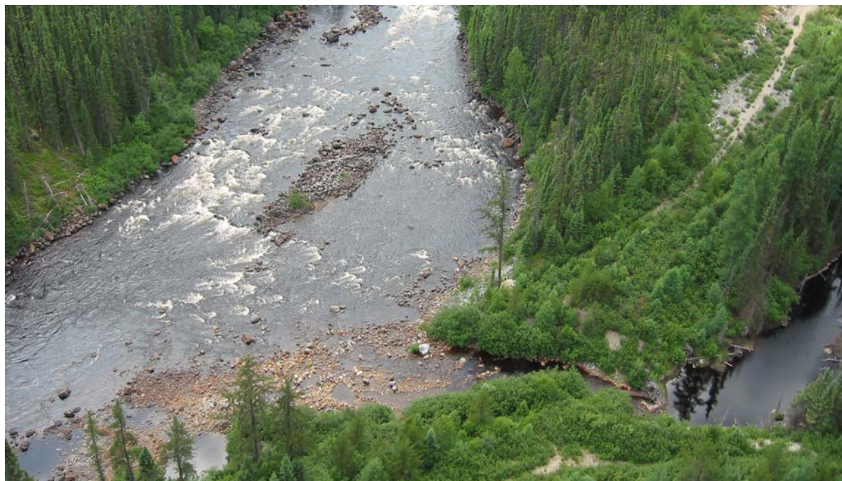
PHOTO 23 — Site d'aménagement d'une digue à l'embouchure du ruisseau TS059
