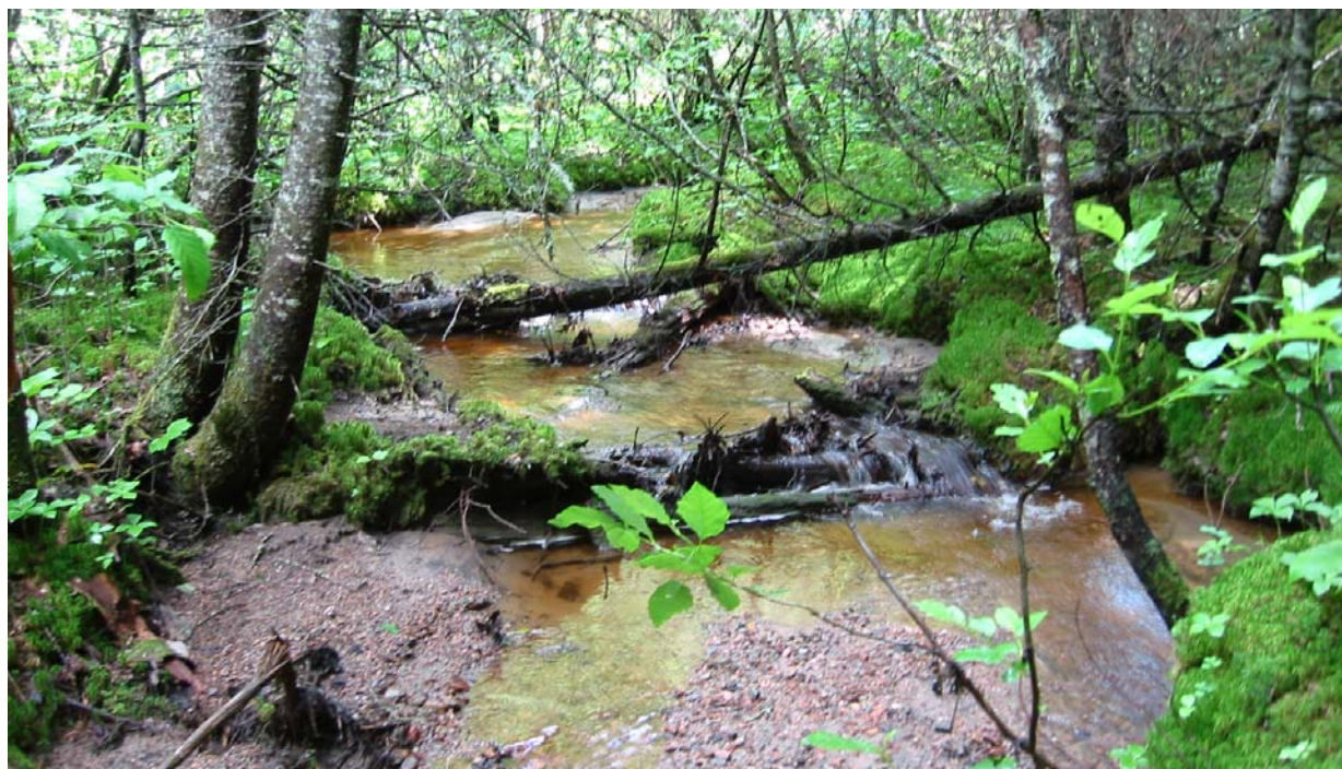
PHOTO 24 — Ruisseau T1846, aménagement d'un seuil
