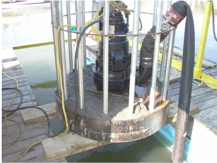
Photo 9 Port de refuge de Saint-Laurent-de-l'Île-d'Orléans - montage de la pompe hydraulique
