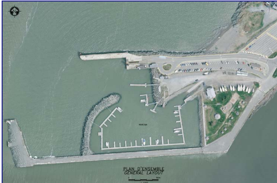
Vue aérienne du site à aménager dans son état actuel (CIMA+)
