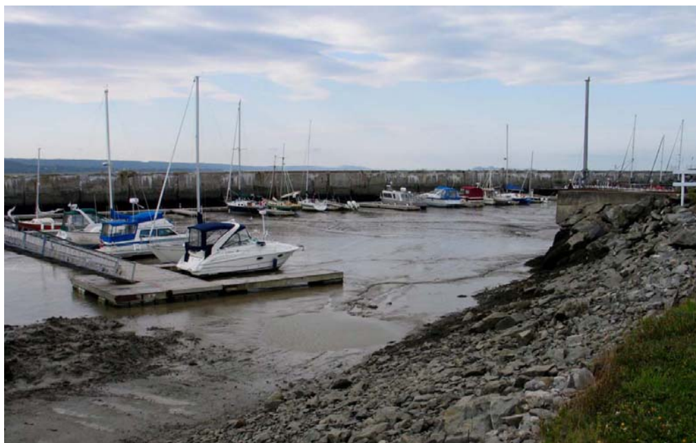
Photo 2 Marina de Rivière-du-Loup à marée basse – situation actuelle.
