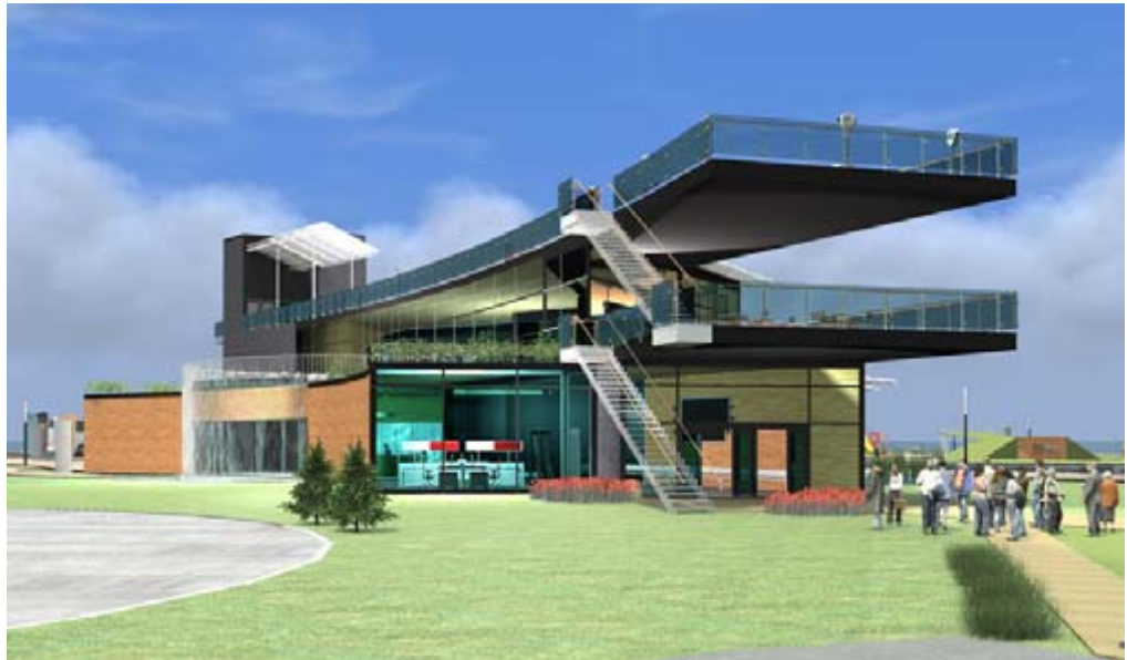
Photo 4 Bâtiment - vue arrière, côté fleuve
