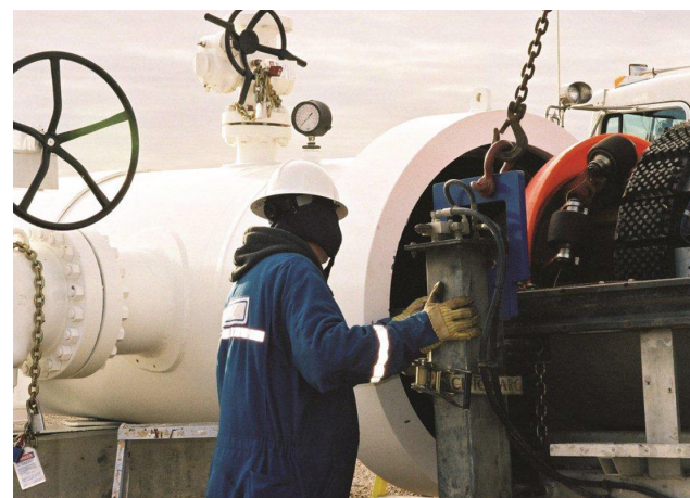
Outil d'inspection interne – Photo : gracieuseté de TransCanada
