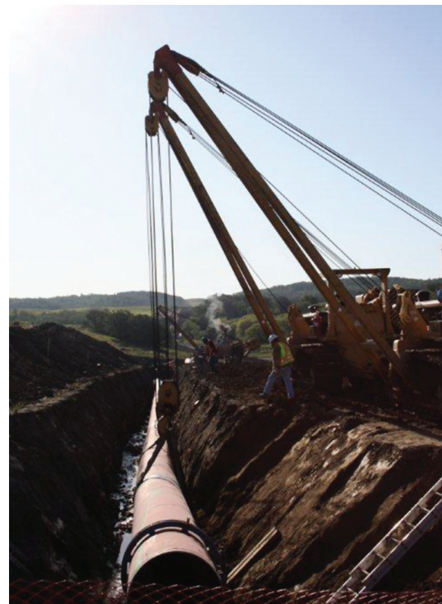
Installation d'un pipeline – Photo : gracieuseté de l'ONÉ
