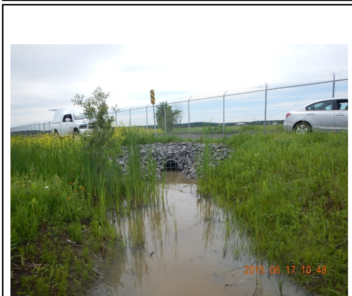
Photo 1 : Vue vers l'aval au site de franchissement
