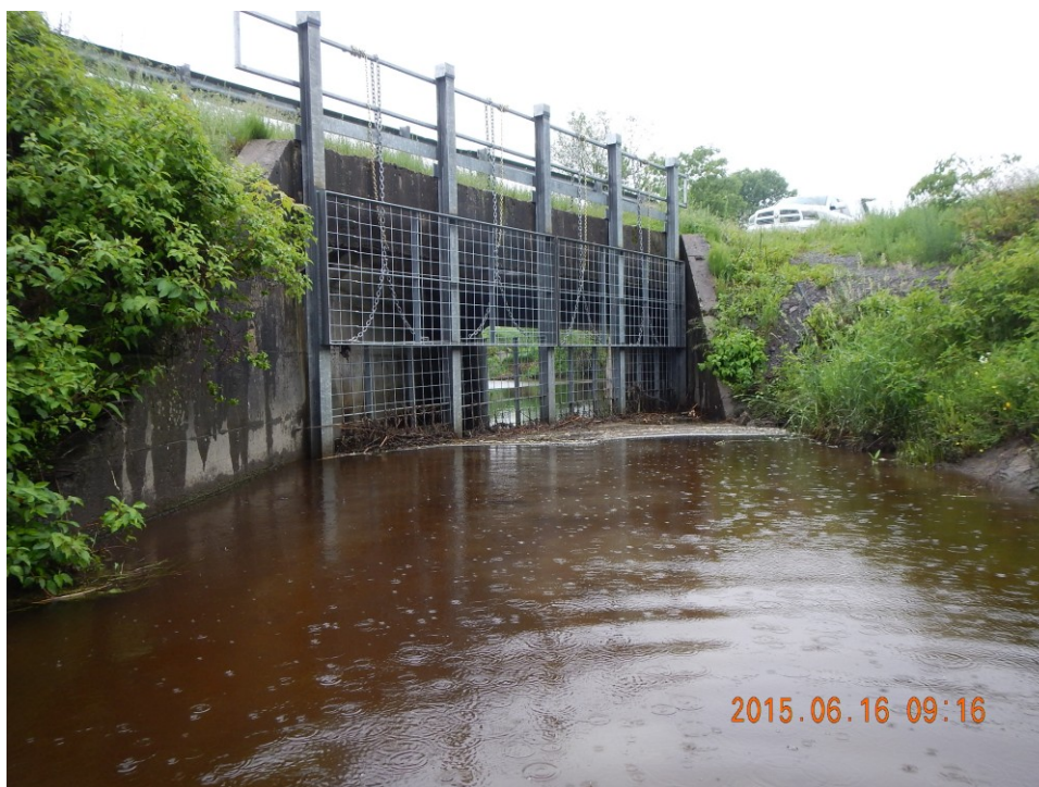
Photo 1 : Vue vers l'aval au site de franchissement
