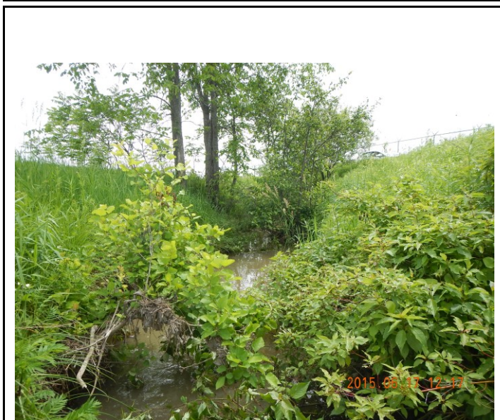
Photo 1 : Vue vers l'aval au site de franchissement
