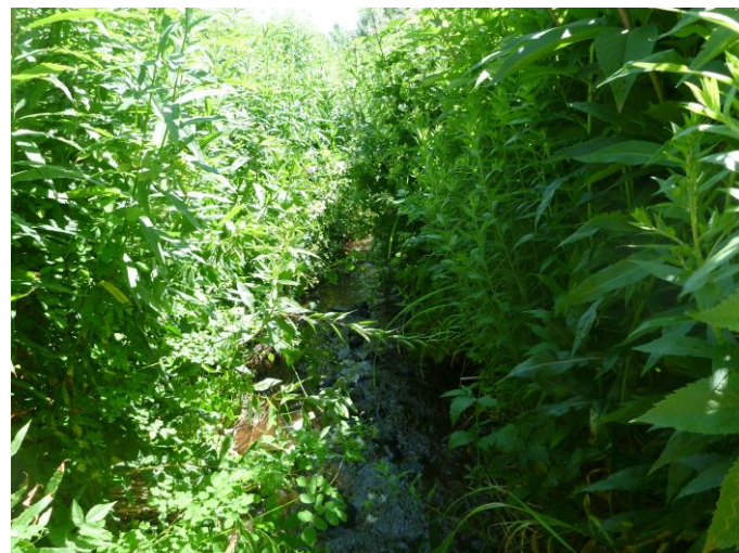
Photo 1 : Vue vers l'aval au site de franchissement
