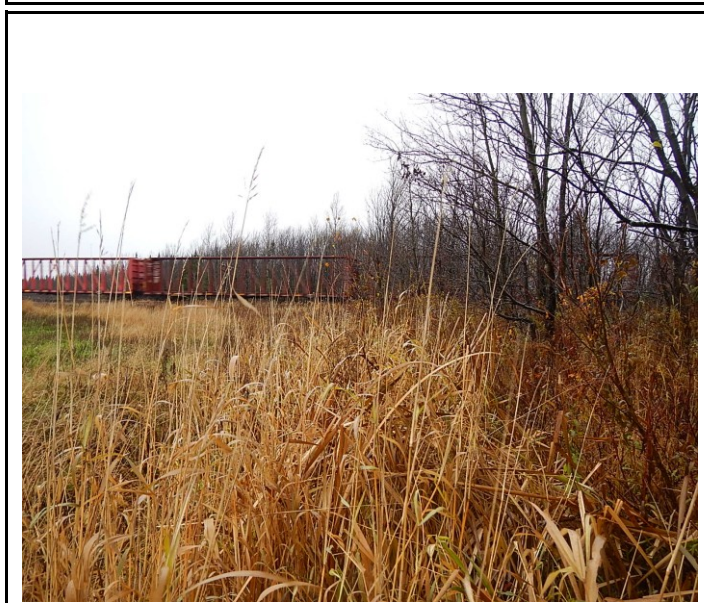
Photo 1 : Vue vers l'aval au site de franchissement
