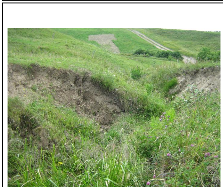
Photo 1 : Vue vers l'aval au site de franchissement
