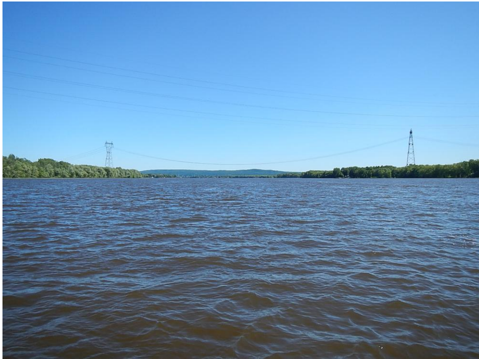
Photo 1 : Vue vers l'aval au site de franchissement
