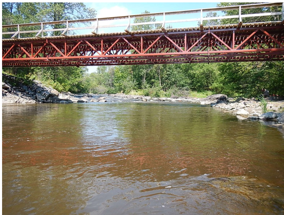
Photo 2 : Vue vers l'amont au site de franchissement
