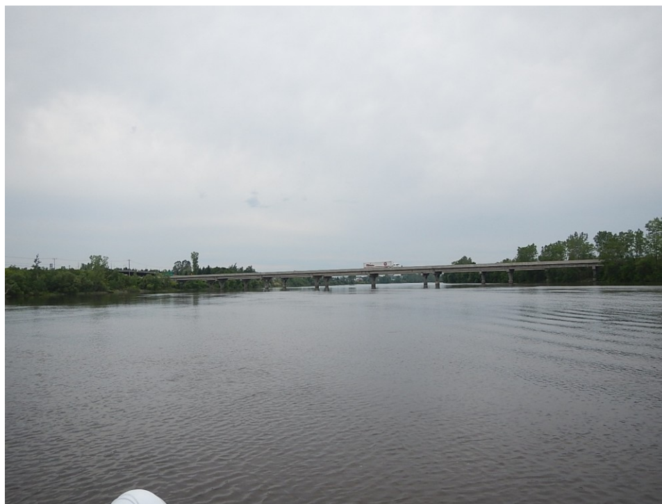
Photo 2 : Vue vers l'amont au site de franchissement
