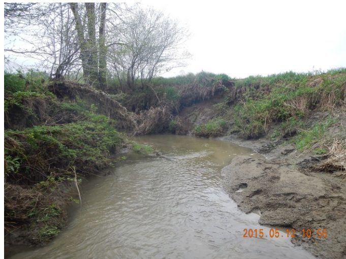
Photo 1 : Vue vers l'aval au site de franchissement
