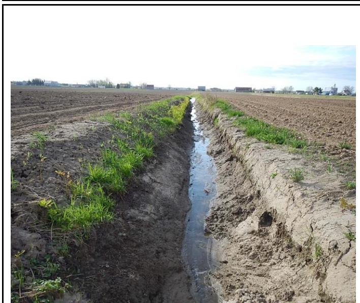
Photo 1 : Vue vers l'aval au site de franchissement
