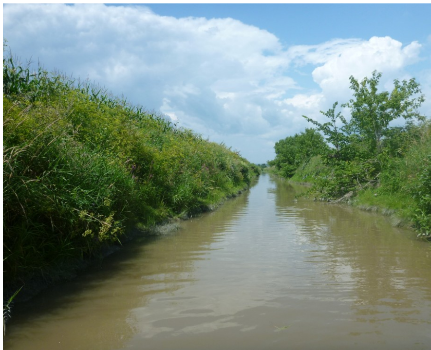
Photo 2 : Vue vers l'amont au site de franchissement
