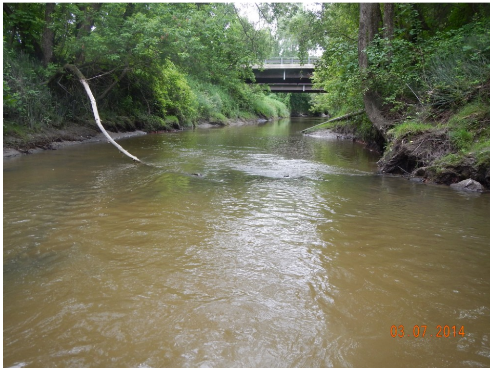
Photo 1 : Vue vers l'aval au site de franchissement
