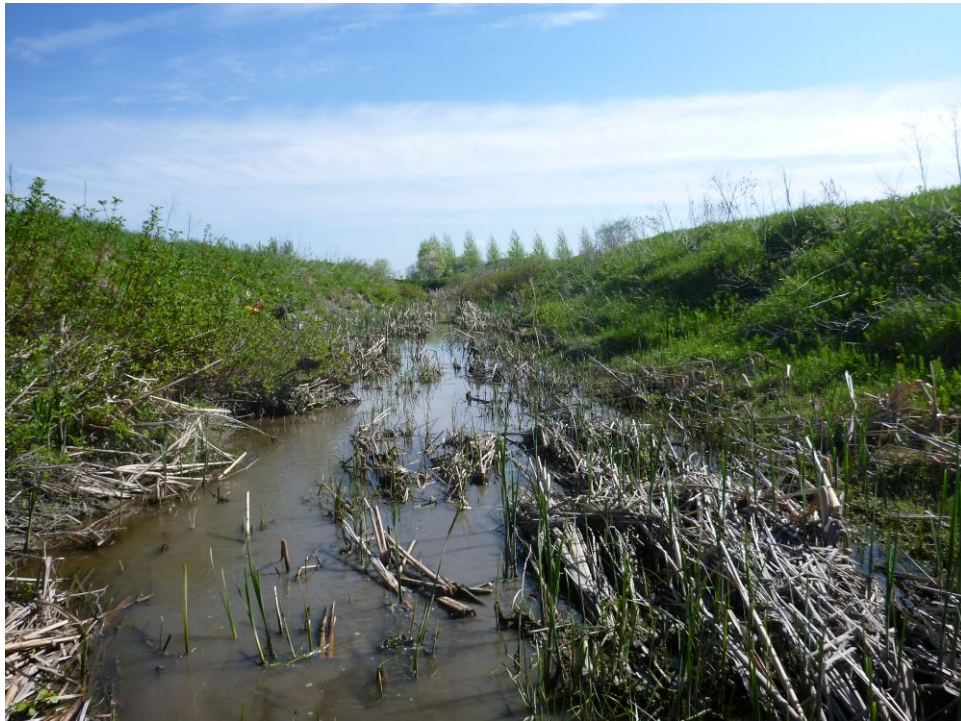
Photo 1 : Vue vers l'aval au site de franchissement
