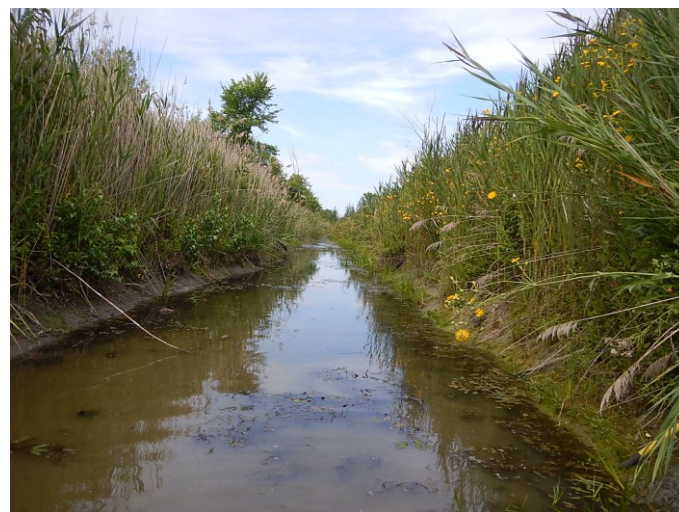
Photo 1 : Vue vers l'aval au site de franchissement
