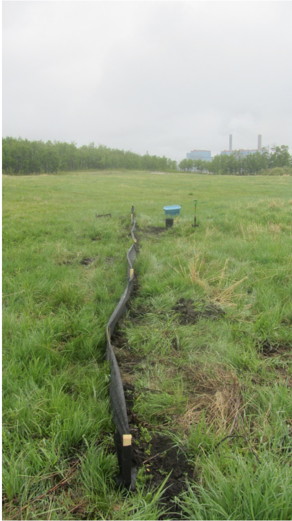
Photo A-1 Clôture d'exclusion fixée
