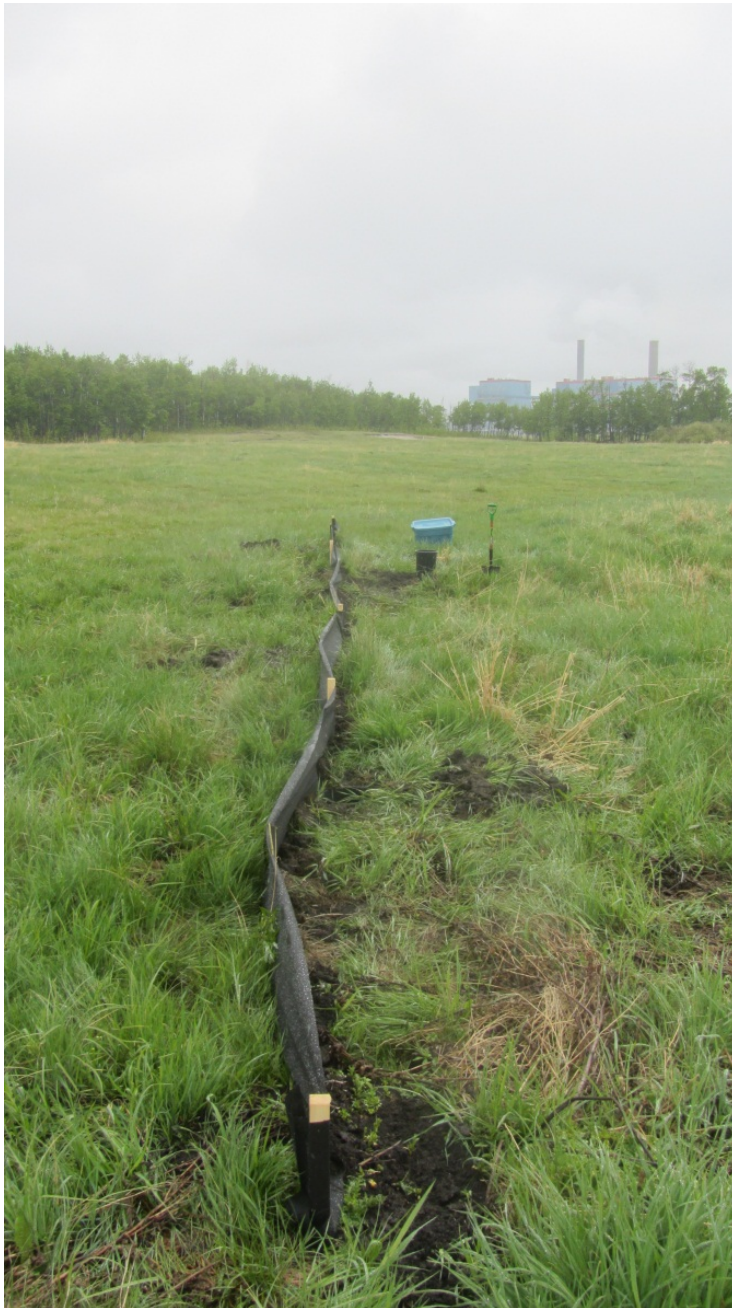
Photo A-1 Clôture d'exclusion fixée
