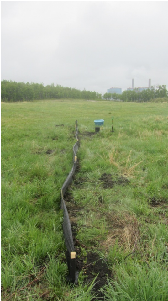
Photo A-1 Clôture d'exclusion fixée
