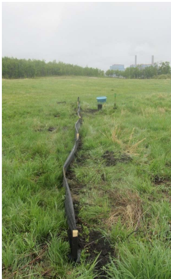
Photo A-2 Clôture d'exclusion fixée
