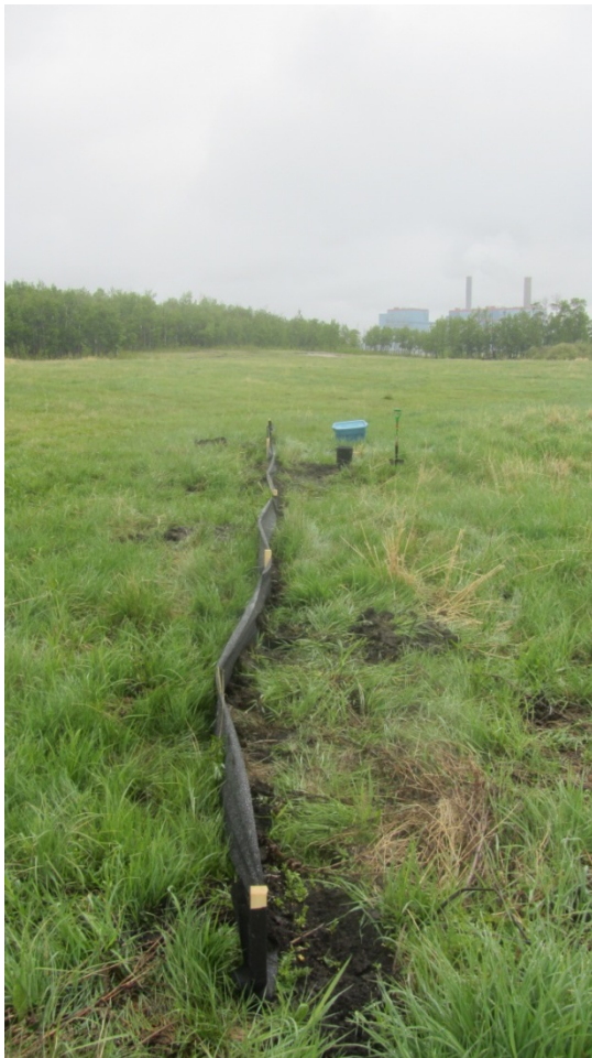
Photo A-1 Clôture d'exclusion fixée
