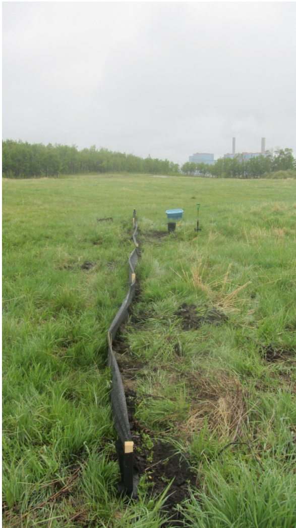
Photo A-1 Clôture d'exclusion fixée
