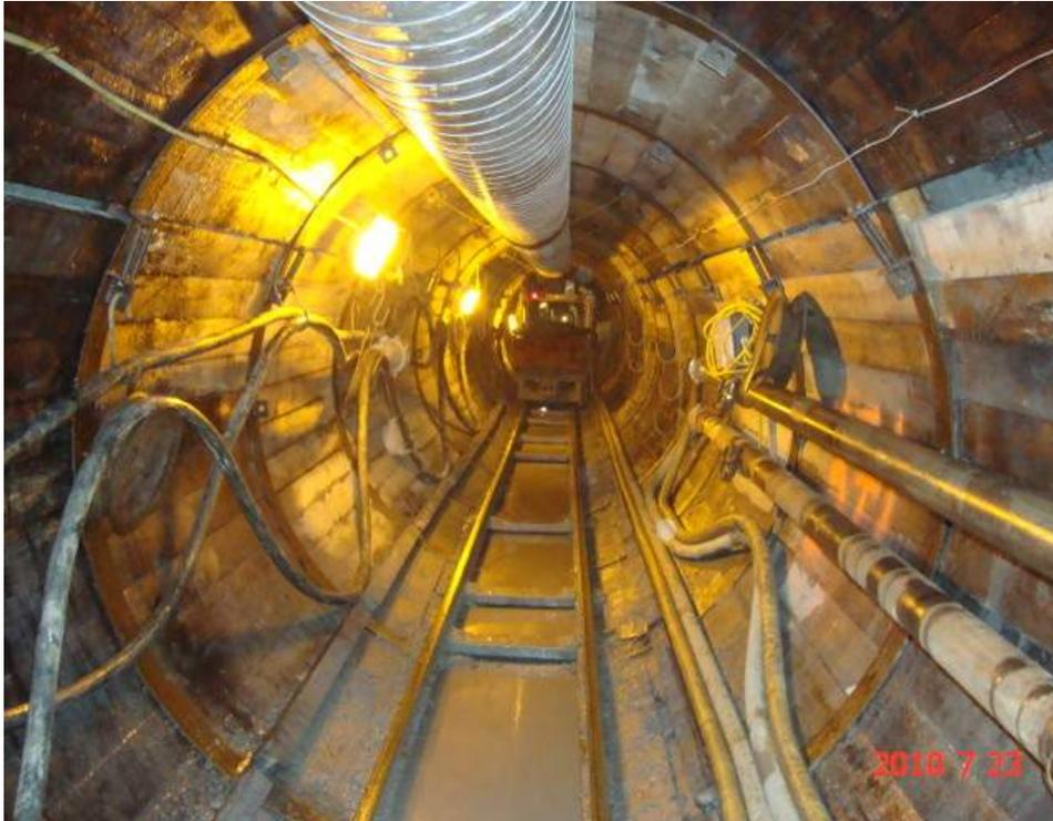
**FIGURE 5-6 – EXEMPLE D’UN TUNNEL AVEC UN SOUTÈNEMENT TEMPORAIRE DE CINTRES METALLIQUES ET DES MOISES EN BOIS.**
