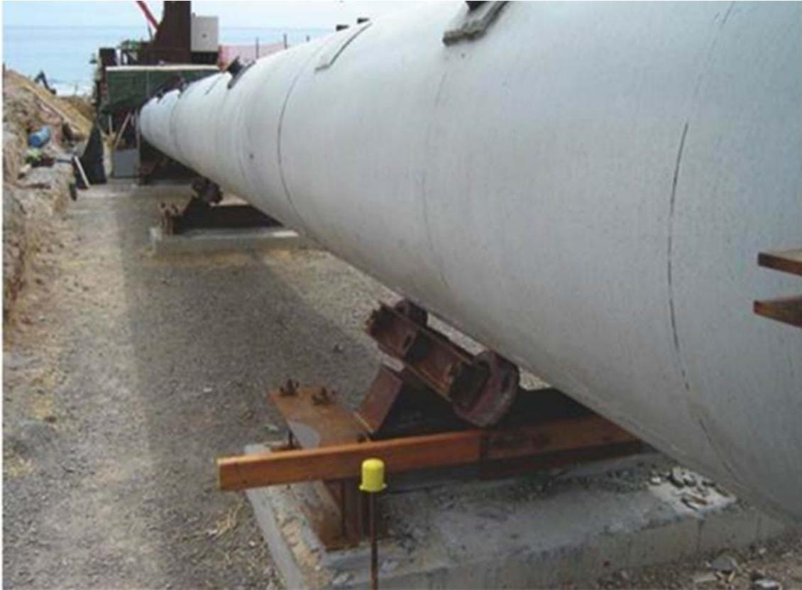
**FIGURE 6-8 – EXEMPLE DE TUYAU QUI SONT TRANSPORTES SUR DES ROULEAUX (COURTOISIE DE RICHMOND PIPE ROLLERS).**
