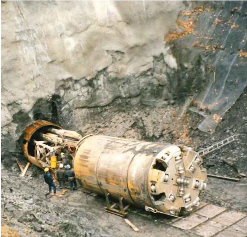
**FIGURE 3-8 – RETRAIT DU TUNNELIER AU TUNNEL TQM.**
