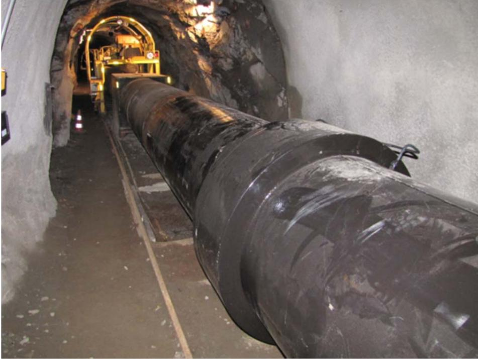
**FIGURE 9-4 – TUYAU INSTALLE DANS LE TUNNEL TAL (LE VEHICULE DE MAINTENANCE EST EN ARRIERE DE LA PHOTO).**
