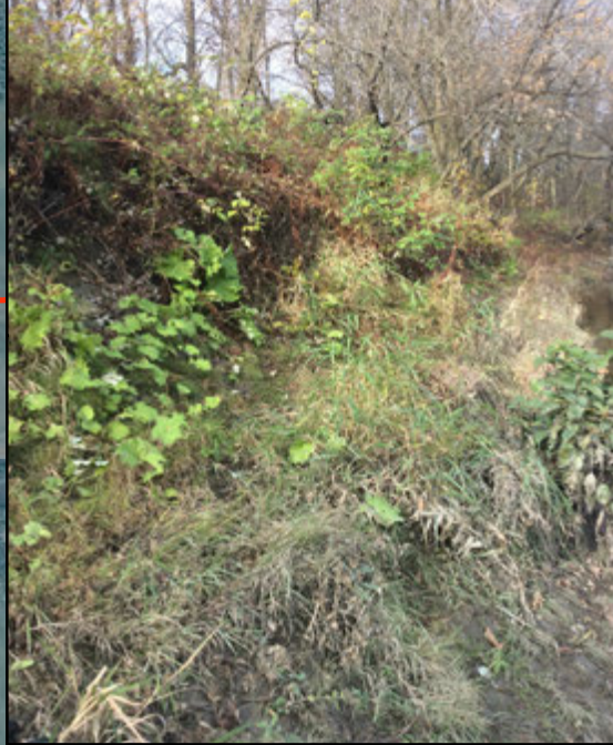
PHOTO 1: VUE MONTRANT L'ÉROSION SUR LE TALUS DROIT DE LA VALLÉE
