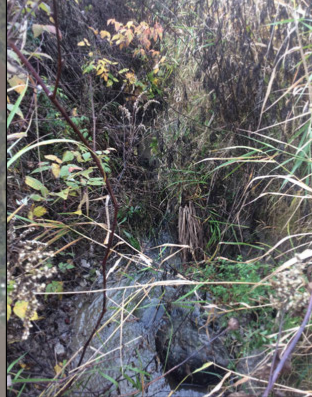
PHOTO 4: VUE VERS L'AVAL
