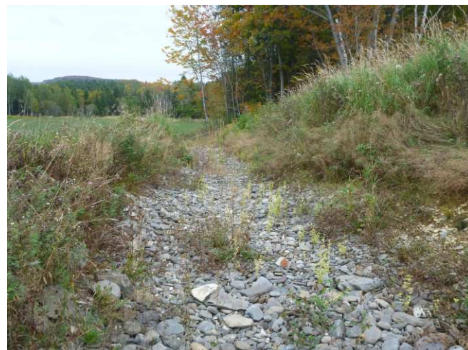
Photo 1 : Vue vers l'aval au site de franchissement
