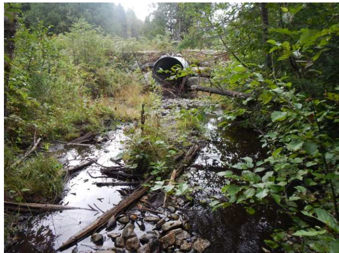
Photo 1 : Vue vers l'aval au site de franchissement
