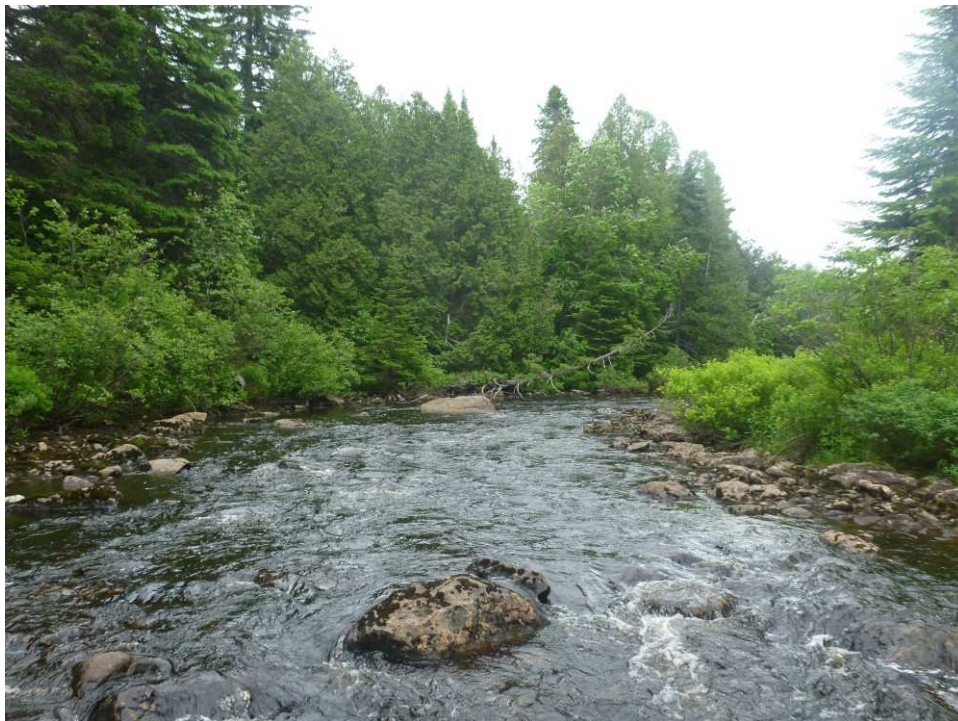
Photo 2 : Vue vers l'amont au site de franchissement
