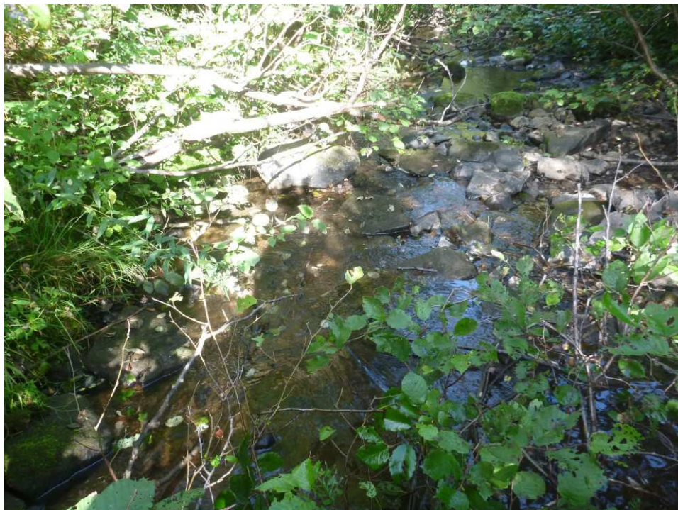
Photo 1 : Vue vers l'aval au site de franchissement
