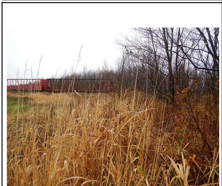
Photo 1 : Vue vers l'aval au site de franchissement
