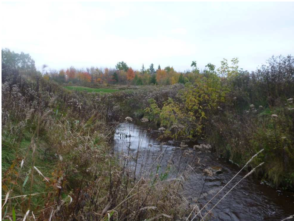
Photo 2 : Vue vers l'amont au site de franchissement
