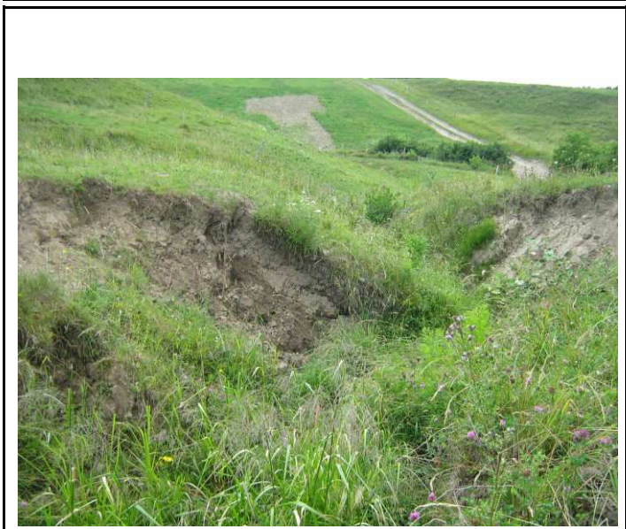
Photo 1 : Vue vers l'aval au site de franchissement
