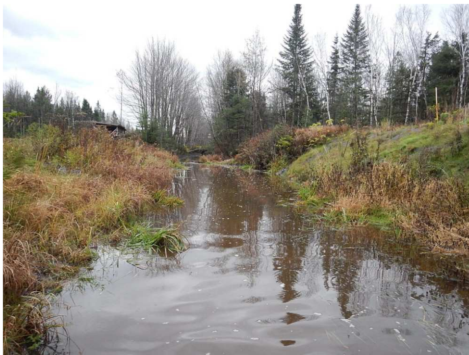
Photo 2 : Vue vers l'amont au site de franchissement
