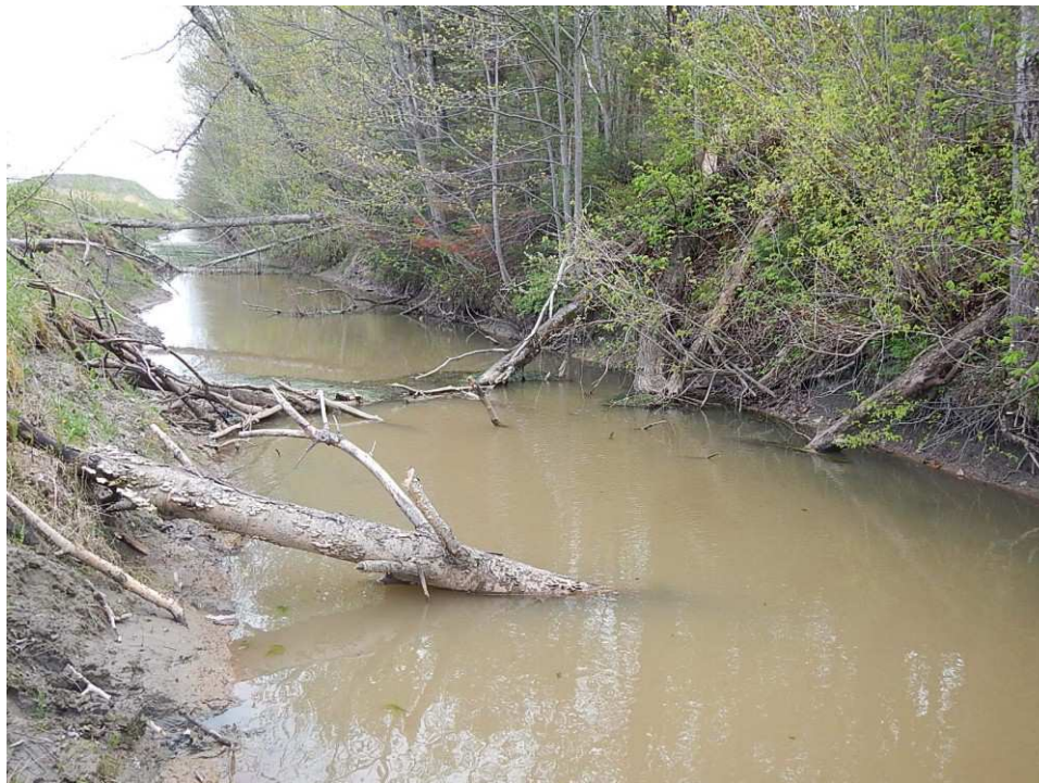
Photo 2 : Vue vers l'amont au site de franchissement
