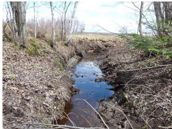
Photo 1 : Vue vers l'aval au site de franchissement
