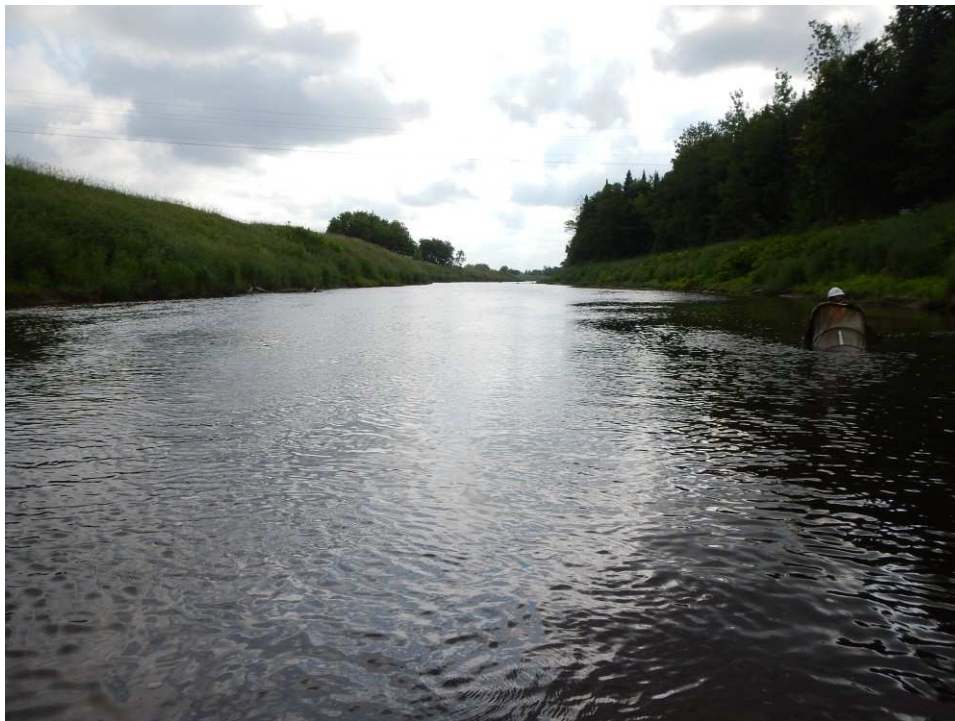
Photo 1 : Vue vers l'aval au site de franchissement
