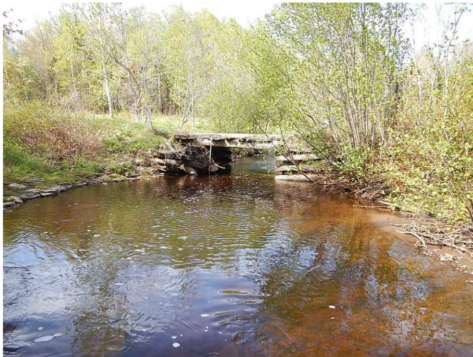
Photo 2 : Vue vers l'amont au site de franchissement
