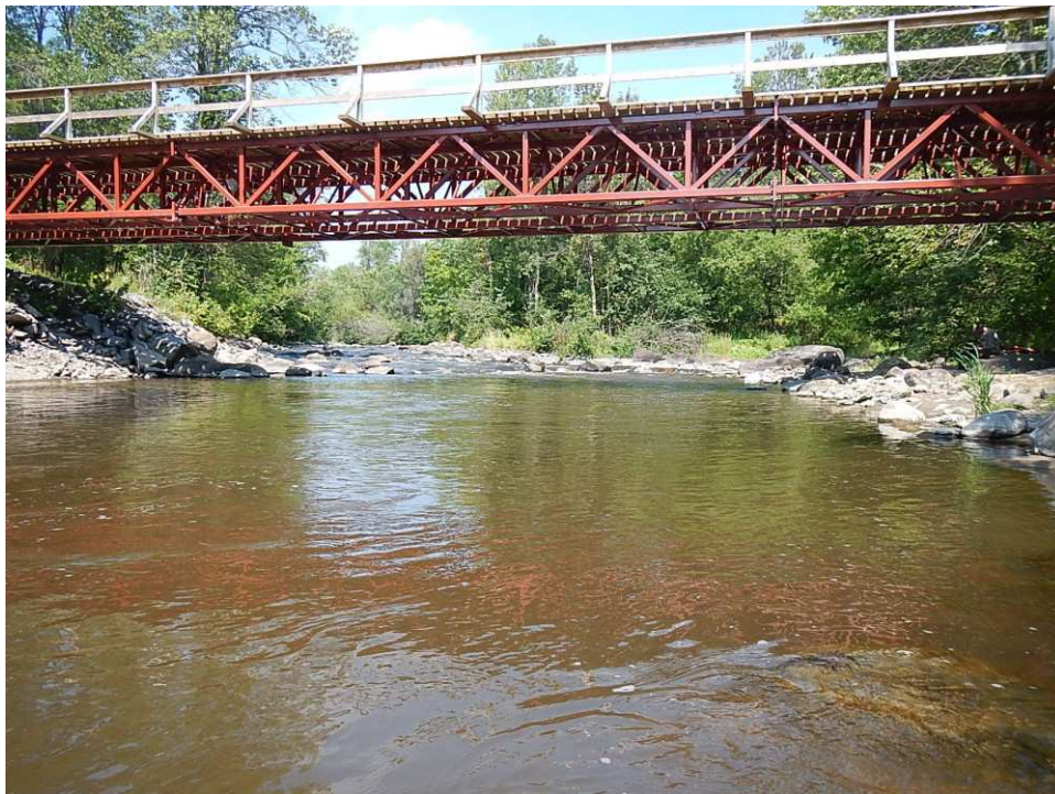
Photo 2 : Vue vers l'amont au site de franchissement
