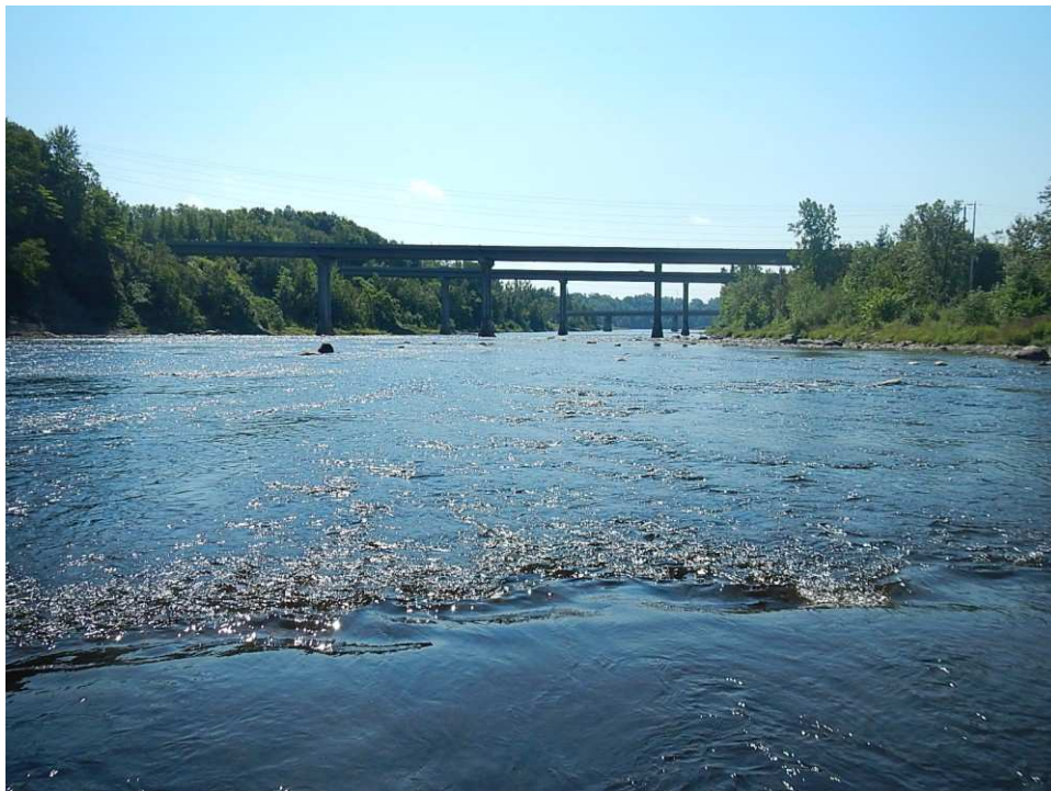
Photo 1 : Vue vers l'aval au site de franchissement
