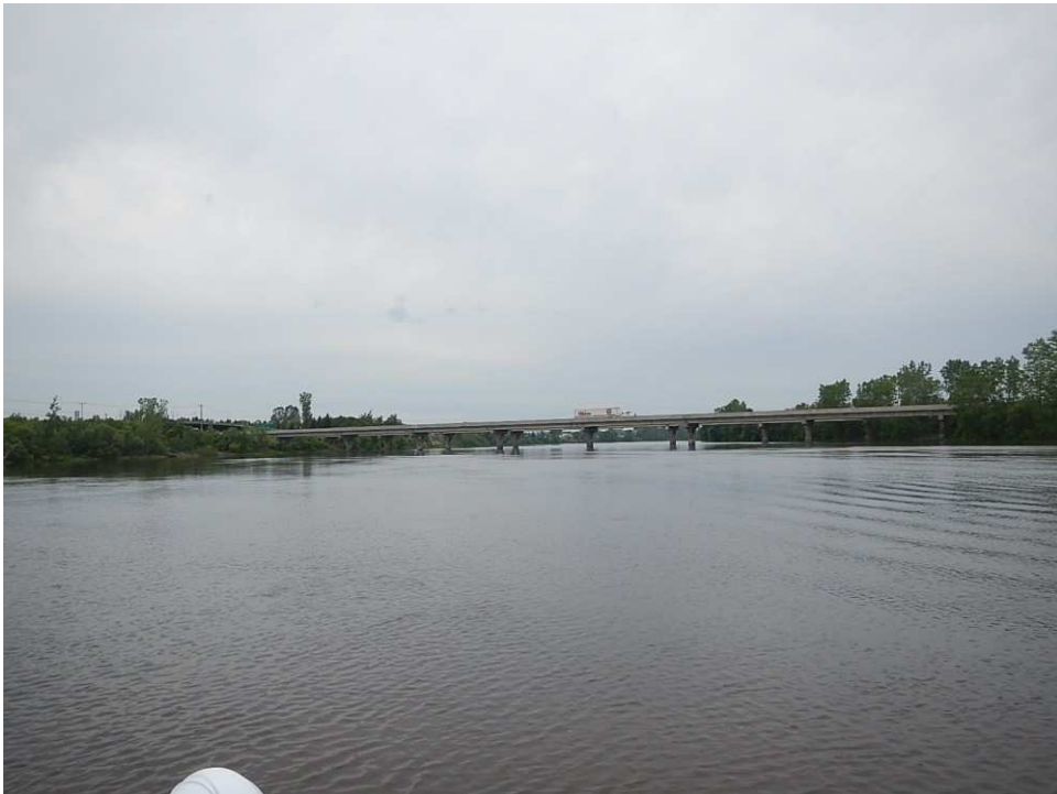
Photo 2 : Vue vers l'amont au site de franchissement
