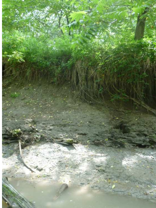
Photo 3 : Vue vers la rive gauche au site de franchissement
