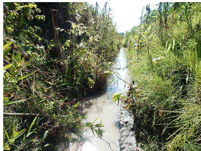
Photo 1 : Vue vers l'aval au site de franchissement
